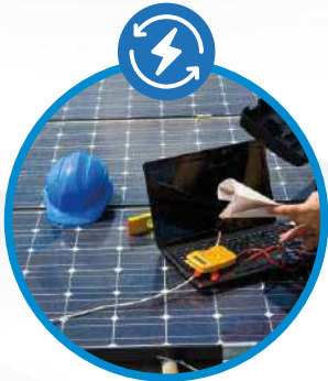
CONTROLLO E MANUTENZIONE IMPIANTI
